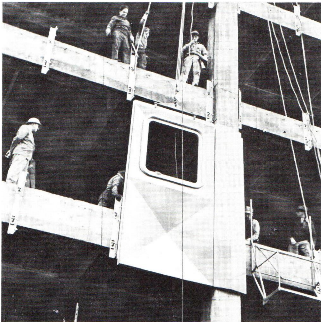
Curtain wall, USA. Frame panels with built-in windows are clamped to the supporting system Curtain wall, USA. Kastenpaneele mit eingebauten Fenstern werden an das Tragsystem geklemmt Mur-rideau, USA. Les panneaux avec fenêtres incorporées sont fixés au système porteur
