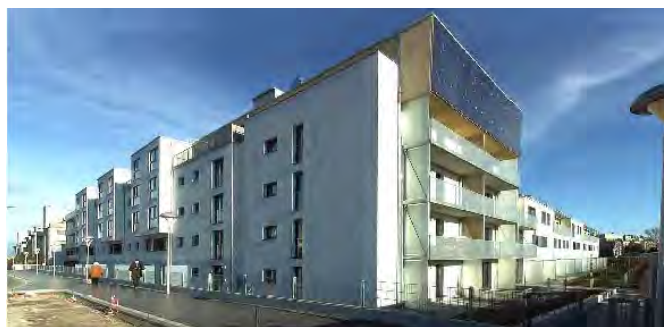
Abbildung 8: Passivhaus Wohnhausanlage Roschégasse (Foto AEE INTEC)
